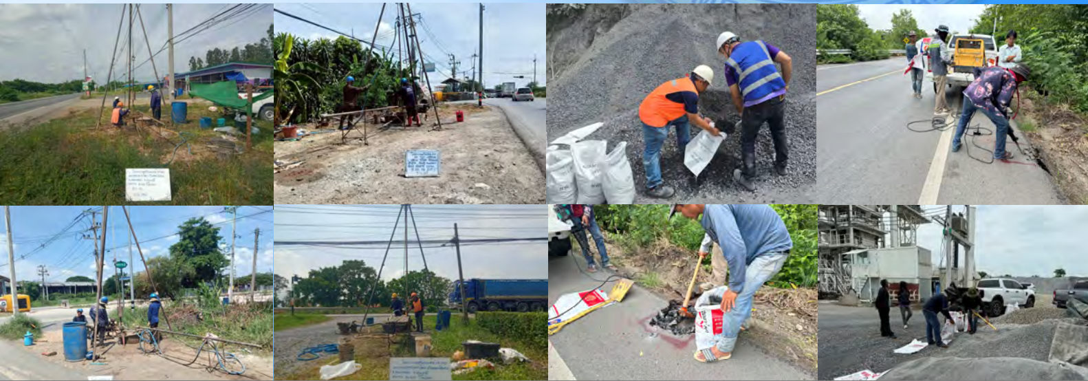
งานเจาะสำรวจดิน (Boring Log) สำหรับงานสะพานและ Bearing Unit
