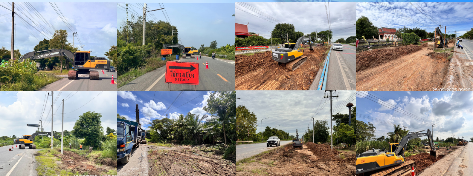
งานถางป่าและขุดต่อ ขนาดเบ
