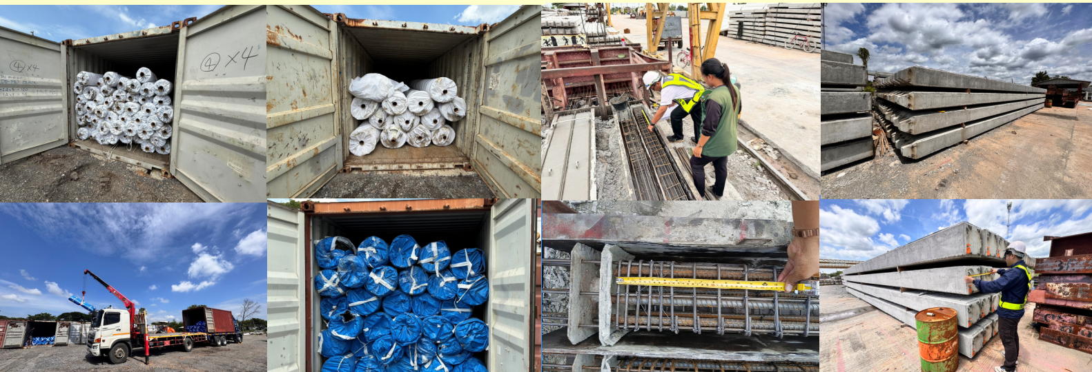
งานกองเก็บแผ่นใยสังเคราะห์ชนิดถักทอ Woven Geotextile, แผ่นตาข่ายเสริม กำลังดิน Geogrid และ แผ่นตาข่ายเสริมกำลังใต้ผิวจราจร Paving Grid
